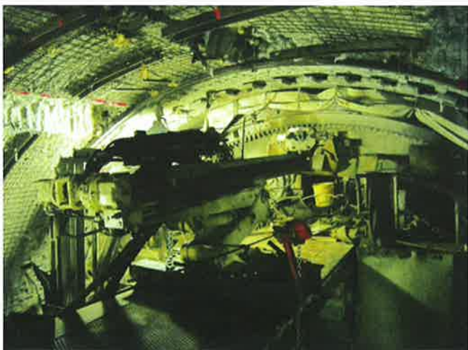
Fig. 2. Drilling rig on the upper deck of a TBM Bild 2. Bohrgerät auf TVM-Oberdeck
